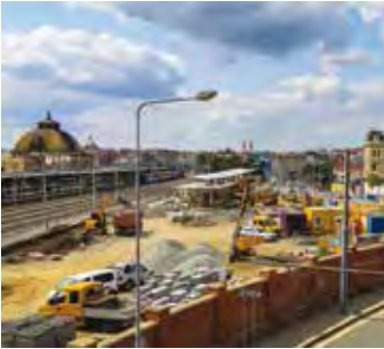
Stavba dopravního uzlu v Šumavské ulici. Foto: Martin Pecuch
