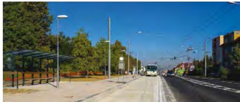
Opravený úsek na náměstí Milady Horákové.
